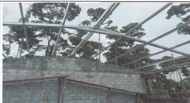
Foto 6: instalación de estructura de techo
