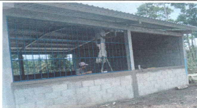
Foto 1: Instalación de ventanas
