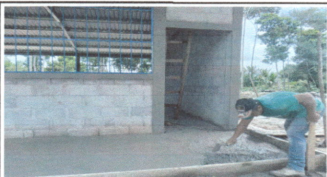
Foto 4: reparación de pisos
