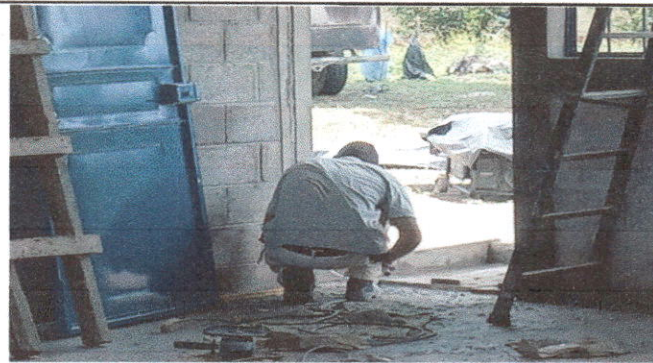
Foto 2: Instalación de puerta
